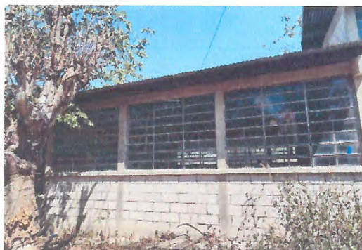
Foto 1: Instalación de balcones tipo barrotes para ventana
